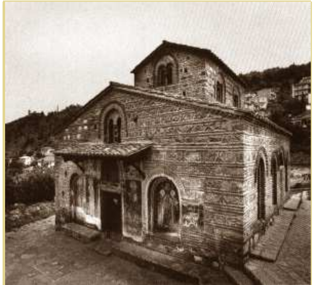
Рис. 17-9. Церковь «Св. Врачи», Костур (Кастория, Греция). Вид с юго-запада. (ЧИЛ4)
