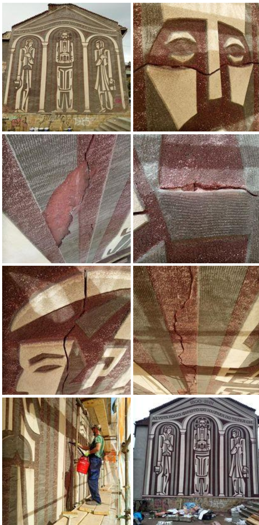
Фиг. 2. Общ изглед, детайли от проблемните участъци и финален изглед, след реновационните дейности на сграфито-паното „Апотеоз“
