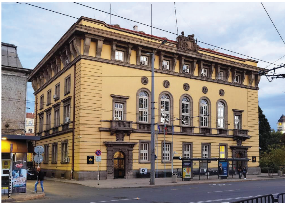
Фигура 1. Изглед на главната фасада от ул. „Христо Ботев“. Сн. Юл. Красовска.
